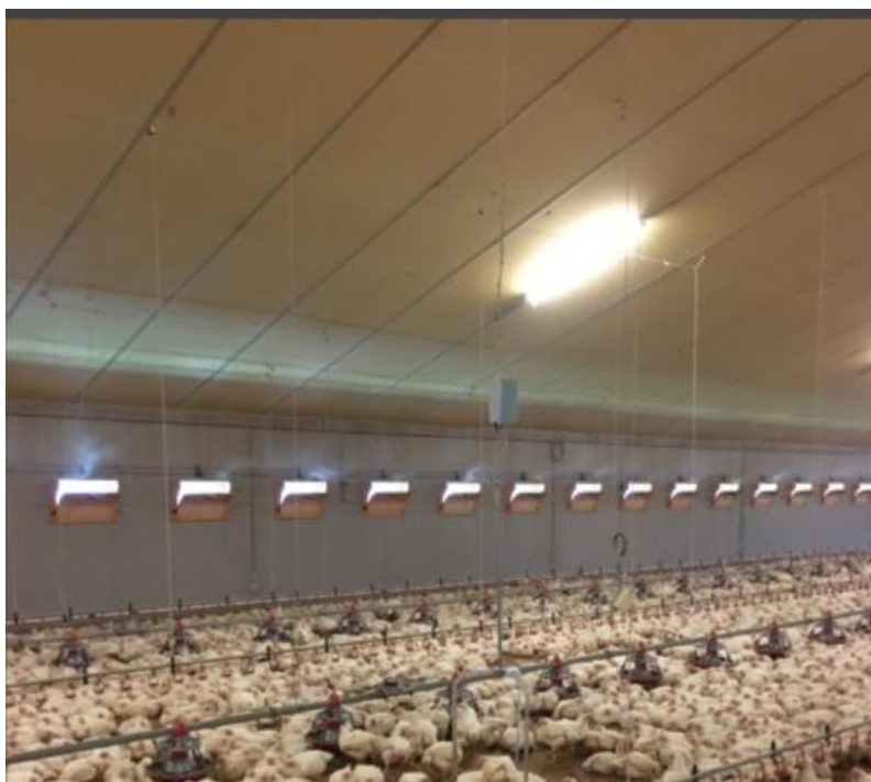
Figuur 2: ventielen in de zijgevel van een vleeskuikenstal
