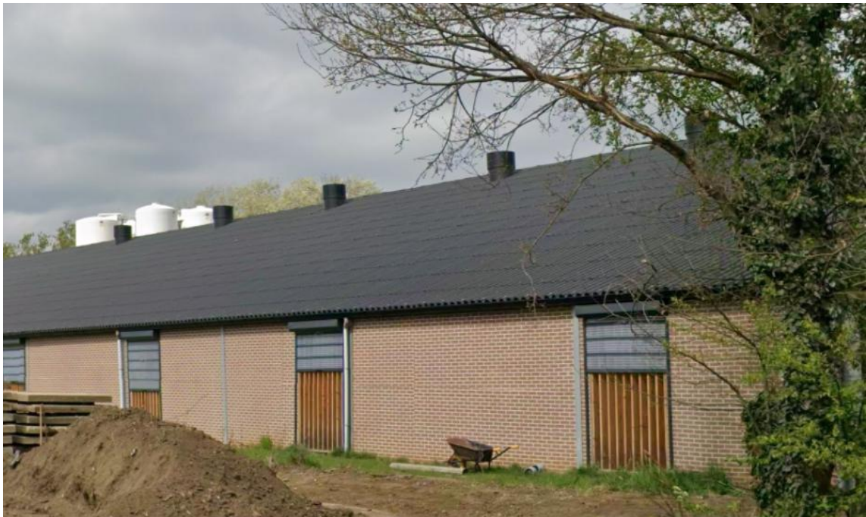
Figuur 1: vleeskalverstal waarbij de luchtinlaat in de zijgevels is voorzien van een regelbaar scherm dat de instroom regelt.
